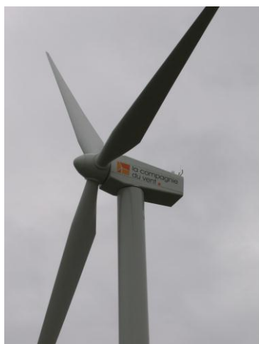
La puissance de chaque machine est de 660 kW
