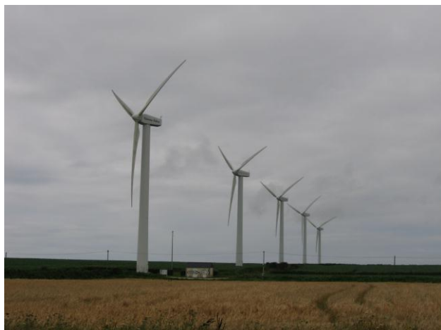
Le petit bâtiment au pied de la première éolienne gère l'ensemble du parc
