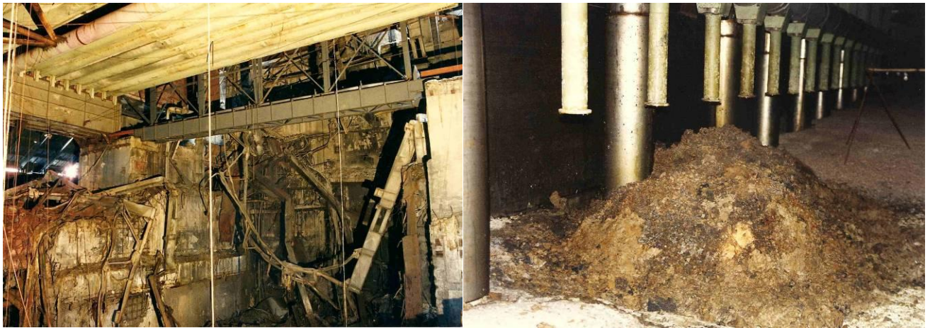
Poutres supportant le Sarcophage
