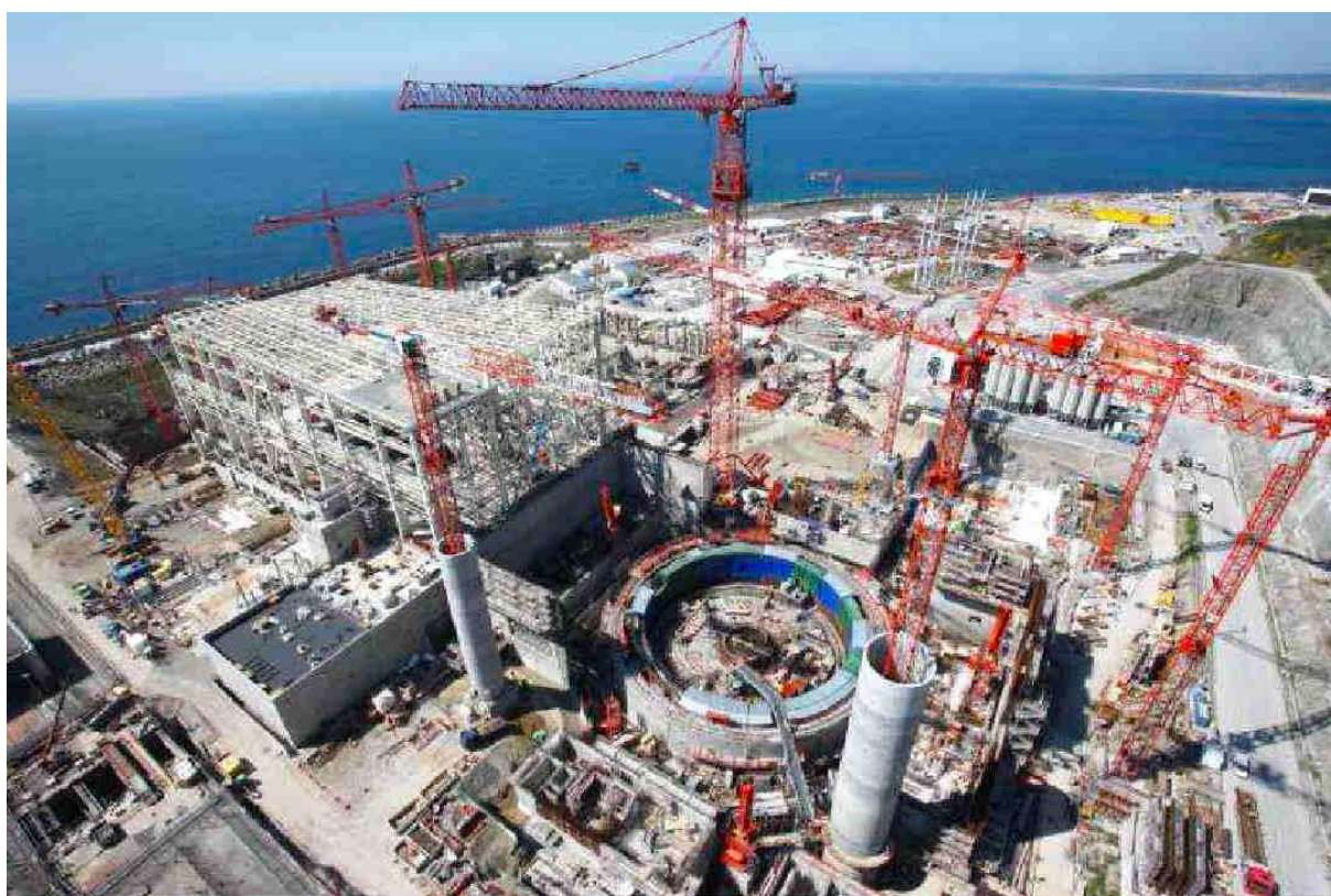
EPR - Flamanville 3 : Vue générale Est - Ouest
