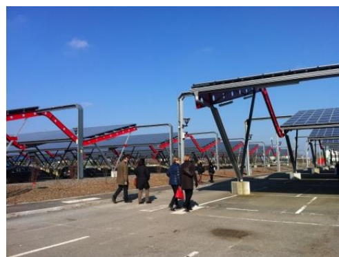
Figure 3 : Centrale photovoltaïque de Bordeaux-lac
