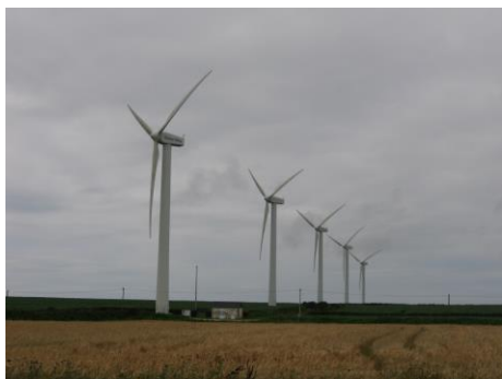
Parc éolien de Plouarzel dans le Finistère
