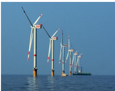
Parc d'éoliennes maritimes
