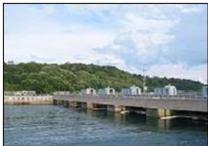
Le barrage de la Rance
