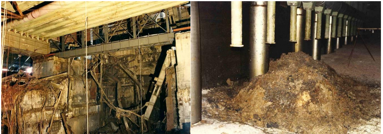
Poutres supportant le Sarcophage
