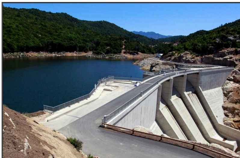
© P. POCHARD / AFP - Centrale hydroélectrique de Rizzanese, Corse.
