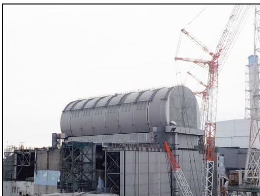
Figure 1 : Vue de la structure recouvrant le bâtiment du réacteur n°3 et des moyens de manutention du combustible qui y sont implantés – Source TEPCO.
