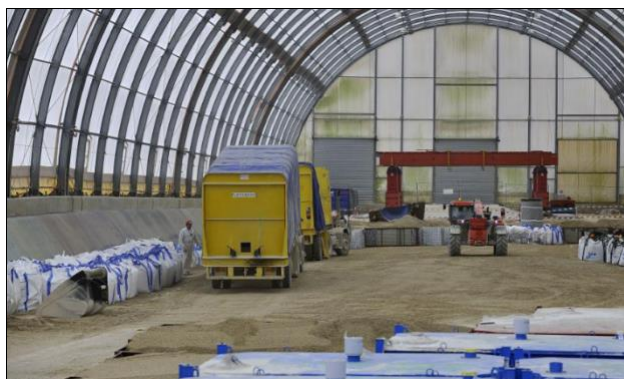
Figure 8 : Alvéole en cours de remplissage au Cires
