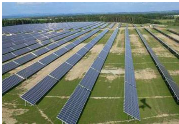
Centrale de puissance Pocking (Allemagne) 62000 modules
