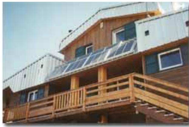
Installation autonome Refuge de Bésines (Hautes Pyrénées)
