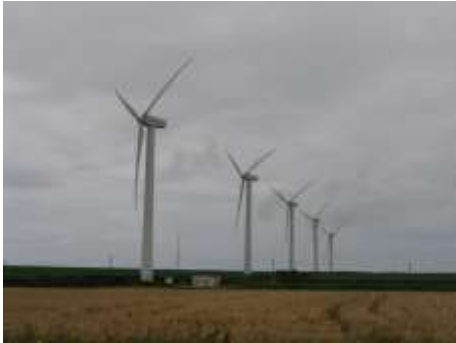
Parc éolien de Plouarzel dans le Finistère
