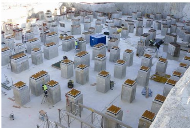
Les bâtiments reposent sur des plots anti-sismiques
