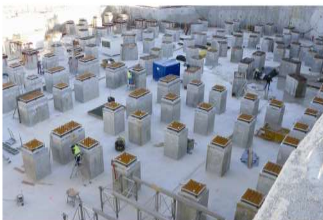
Les bâtiments reposent sur des plots anti-sismiques
