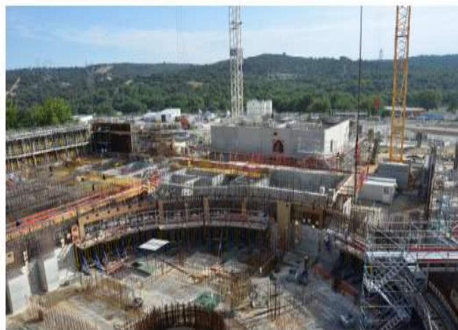
Vue du chantier en 2011
