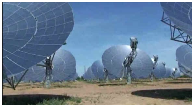
Centrale de Maricopa
