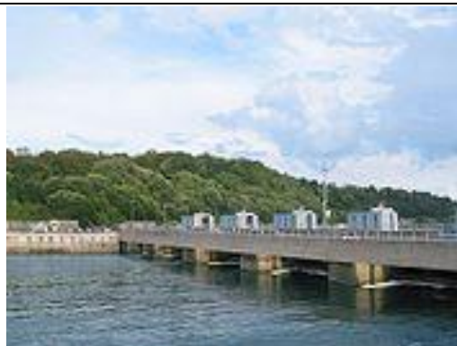
Fig. 4 : Le barrage de la Rance (EDF Rémi Artiges)
