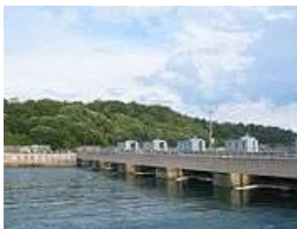
Fig. 4 : Le barrage de la Rance (EDF Rémi Artiges)
