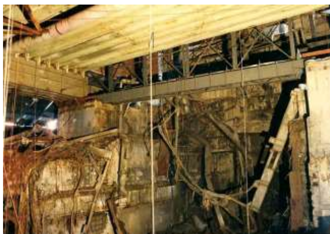
Poutres supportant le Sarcophage
