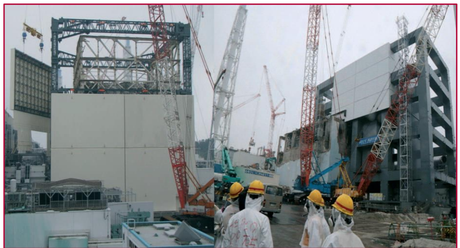
Fig. 1 – Nouvelles enceintes de confinement en cours de montage [1] Réacteur n°1 (terminé en oct. 2012) Piscine n°4 (terminé en oct. 2013)
