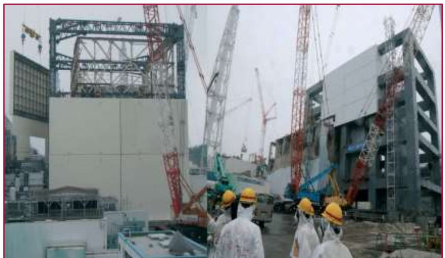
Fig. 1 – Nouvelles enceintes de confinement en cours de montage [1] Réacteur n°1 (terminé en oct. 2012) Piscine n°4 (terminé en oct. 2013)
