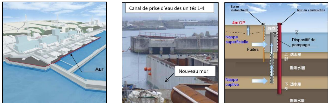
Fig. 3 – Mur d'étanchéité en construction [2d]
