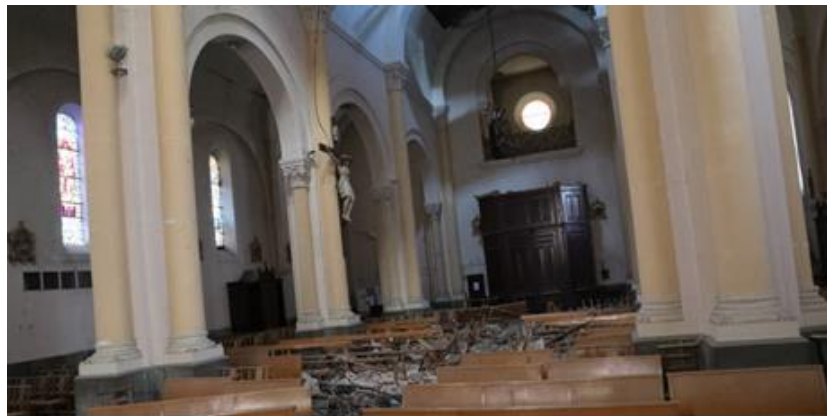
Vue intérieure de l'église du Teil qui, quatre ans après le tremblement de terre s'apprête à disparaître du paysage local.
