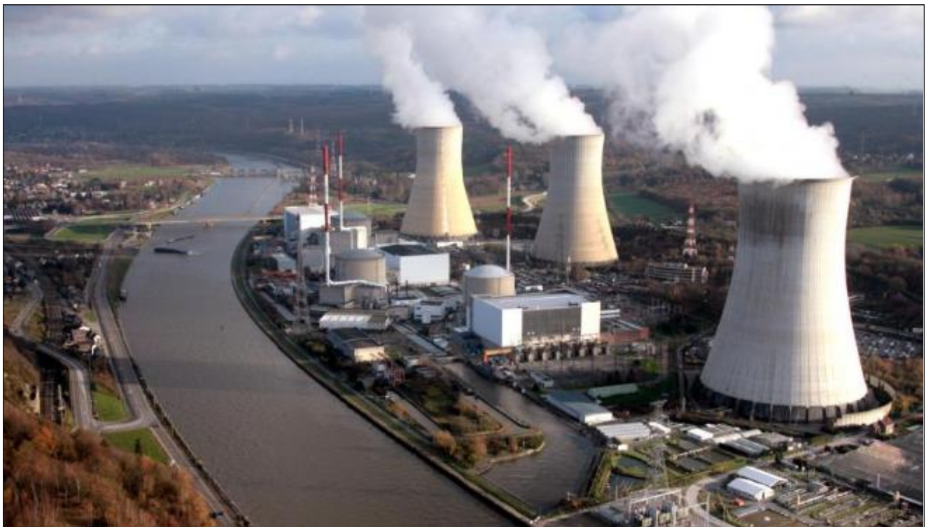
Centrale nucléaire de Tihange (Belgique)
