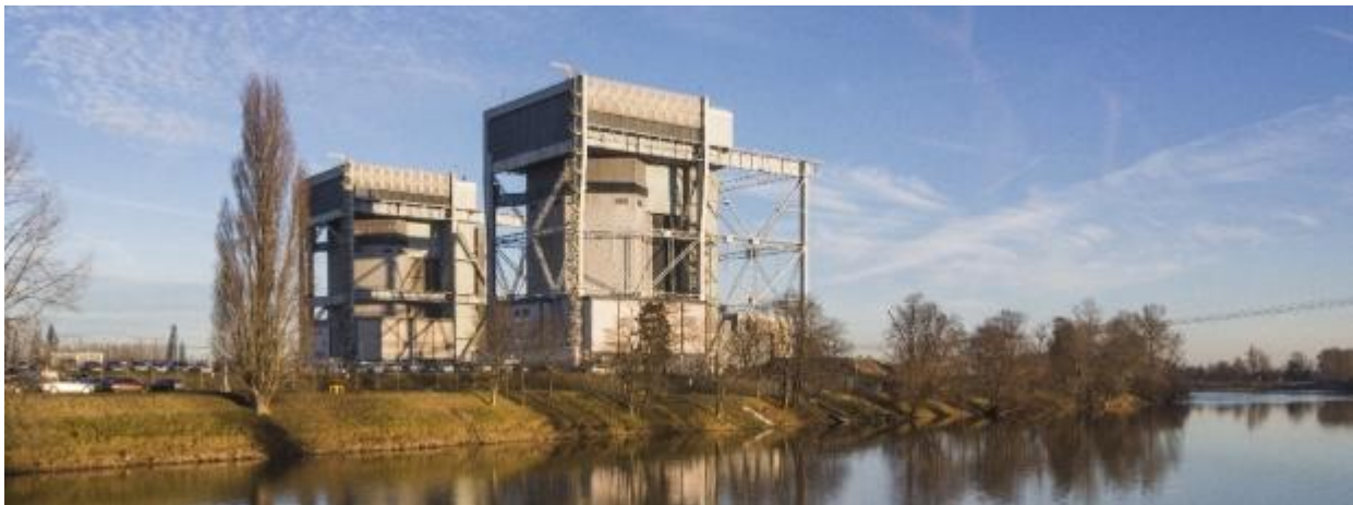
Vue de la centrale de Saint-Laurent-des-Eaux (graphite-gaz)
