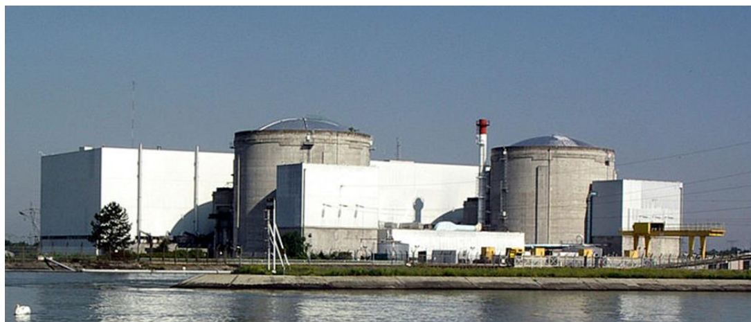
Centrale nucléaire de Fessenheim (Haut-Rhin)
